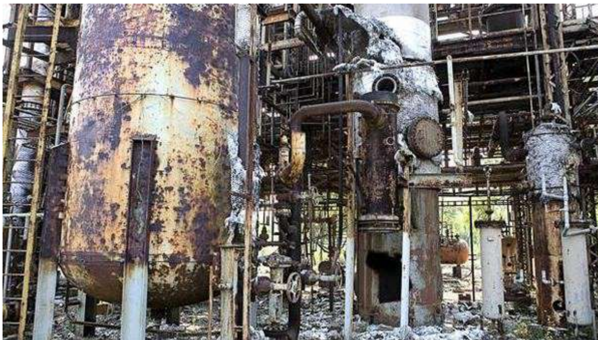
Figura 8. Aspecto actual de la planta de Bhopal.
